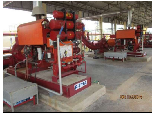
ภาพถ่ายที่ 2.2-27 เครื่องสูบน้ำดับเพลิง
