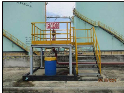
ภาพถ่ายที่ 2.2-28 ระบบฉีดน้ำดับเพลิงแบบโฟมและระบบผสมโฟมสำหรับดับเพลิง
