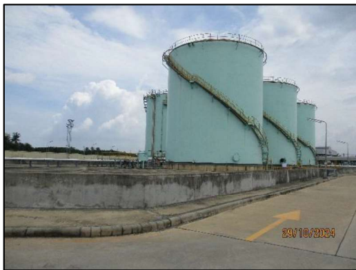
ภาพถ่ายที่ 2.2-3 คั่นคอนกรีตล้อมรอบถังเก็บน้ำมัน
