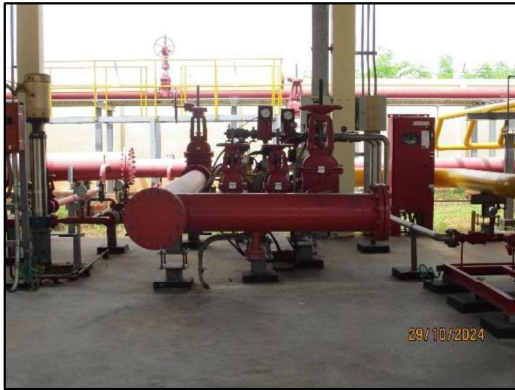
ภาพถ่ายที่ 2.2-27 เครื่องสูบน้ำดับเพลิง
