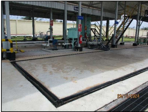
ภาพถ่ายที่ 2.2-19 รางระบายน้ำปนเปื้อนน้ำมัน
