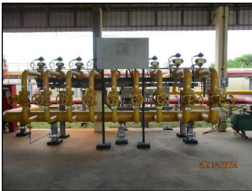
ภาพถ่ายที่ 2.2-28 ระบบฉีดน้ำดับเพลิงแบบโฟมและระบบผสมโฟมสำหรับดับเพลิง
